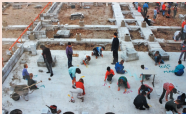
De leerlingen druk bezig bij de realisatie van het definitieve schoolgebouw van 't Schrijverke
